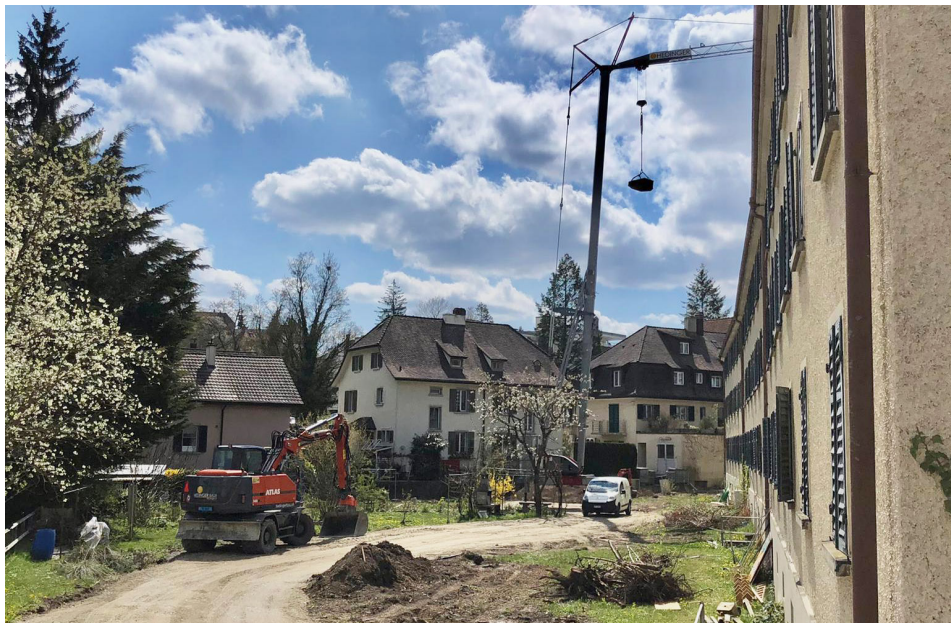
Start der Bauarbeiten am Schlössliweg im Frühjahr 2021
