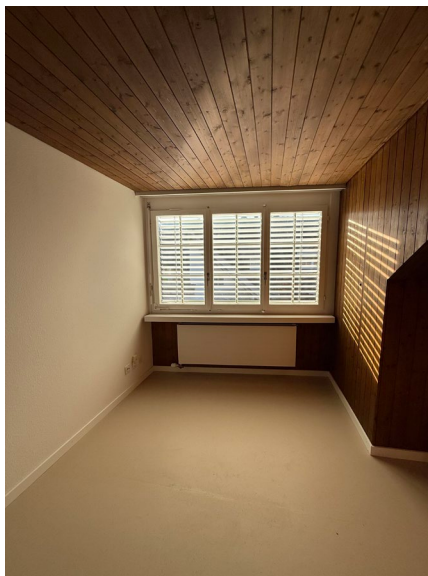
Kleinwohnung nach Sanierung
