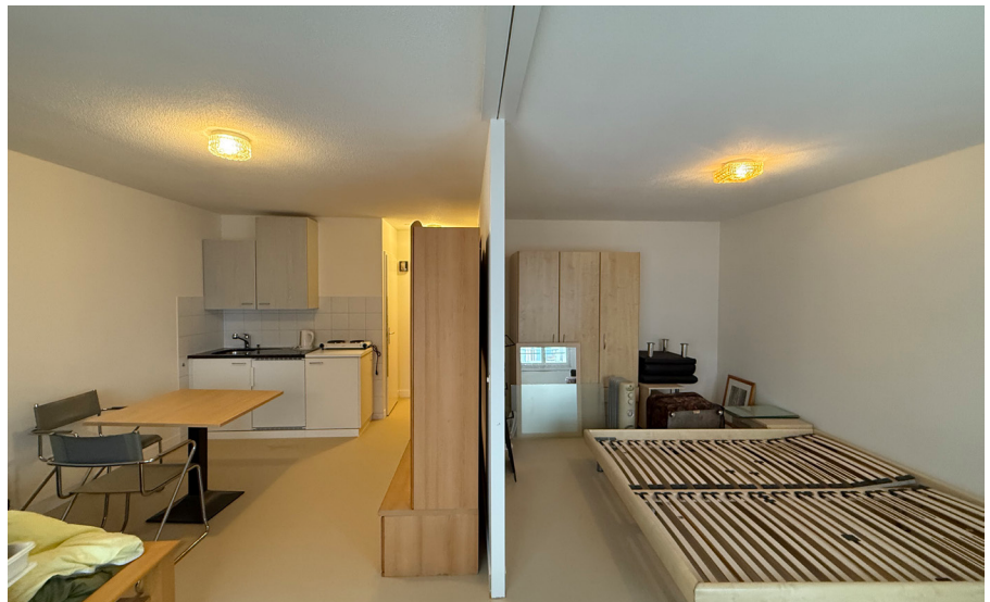
Innenaufnahme nach Oberflächensanierung Whg
