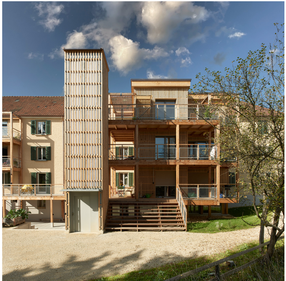
Ansicht Ostfassade Schlössliweg 10
